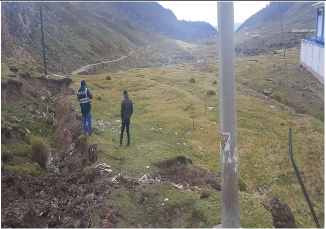
Fotografia 2: Colmatacion, erosion y deslizamiento de las margenes en el cauce Cuyoc
