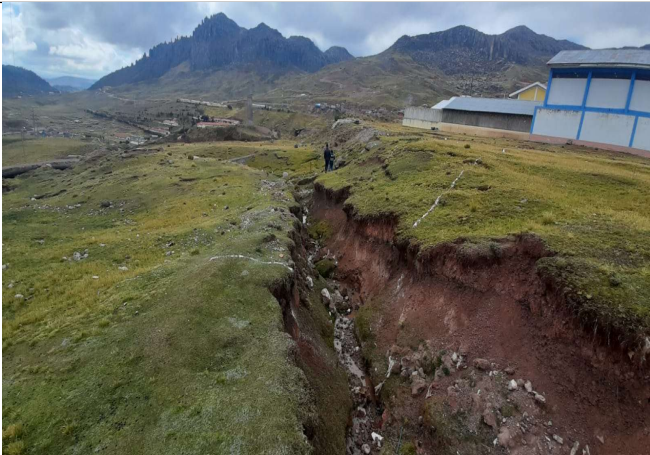
Fotografia 4: Deslizamiento del talud de ambas margenes de la quebrada Cuyoc.
